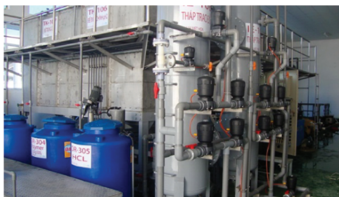
越華電子一~三期(日商) 電鍍廢水900噸/天 - B級排放 CÔNG TY TNHH ĐIỆN TỬ VIỆT HOA (NHẬT BẢN) giai đoạn 1~ 3 Nước thải mạ điện 900m 3 /ngày, tiêu chuẩn B xả thải
